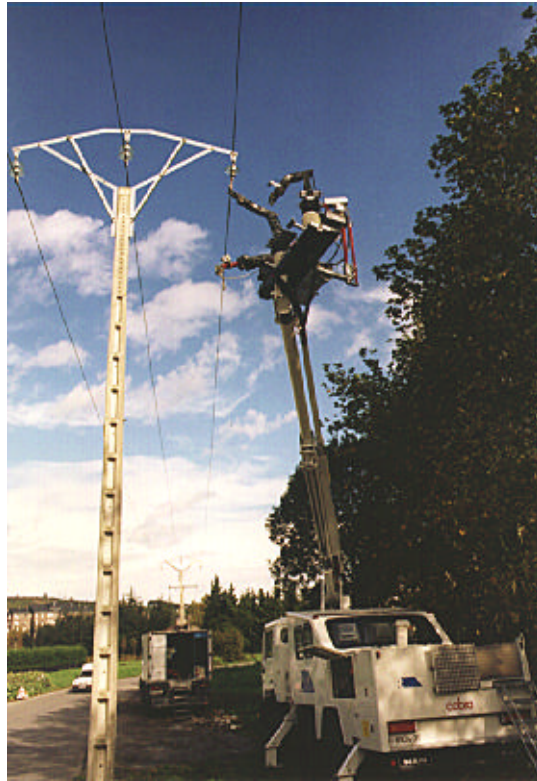
Figura 1. Plataforma con dos manipuladores y plumín de carga del ROBTET
